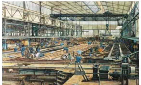
Dessin de 1916 : des ouvriers fabriquent des plaques tournantes qui permettaient aux locomotives et à d'autres engins ferroviaires de faire demi-tour.
