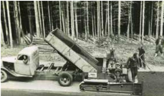
1929 : Le répandeur remorqué assurait la pose de chaussées en asphalte ou en matériaux blancs. Il était tracté par un camion qui l'alimentait également en matériau.
